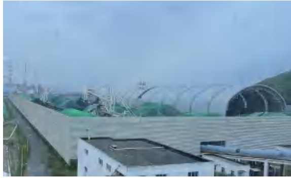
堆场高分子复合材料防风网及条形料仓
