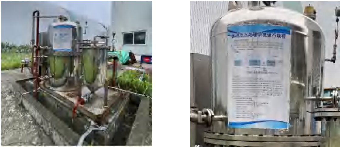
图 6.1-1 企业机修间含油污水处理系统
