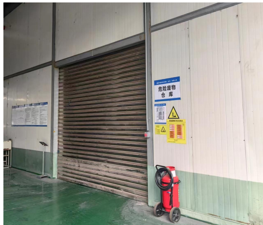
危废库外部照片
