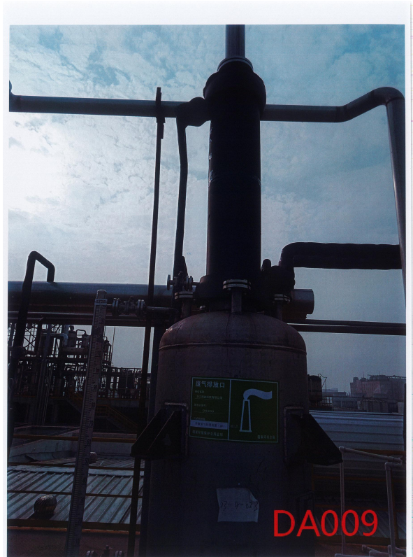
RTO 废气焚烧装置
