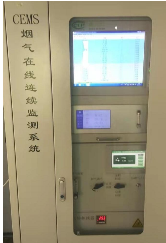
废气在线监测设备
