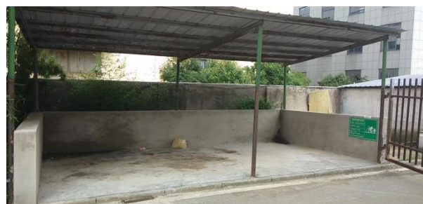
一般固废贮存场所
