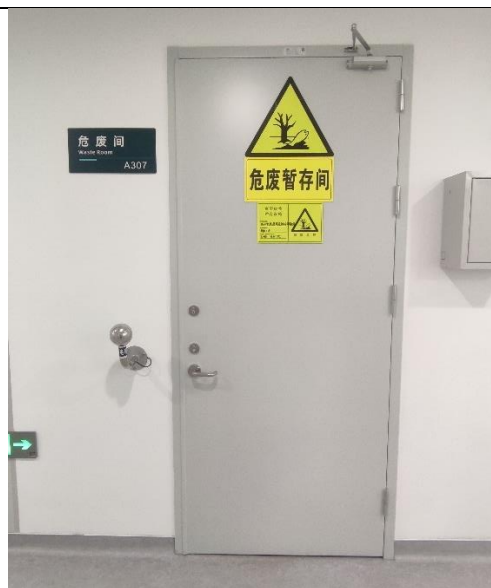
危险废物暂存间
