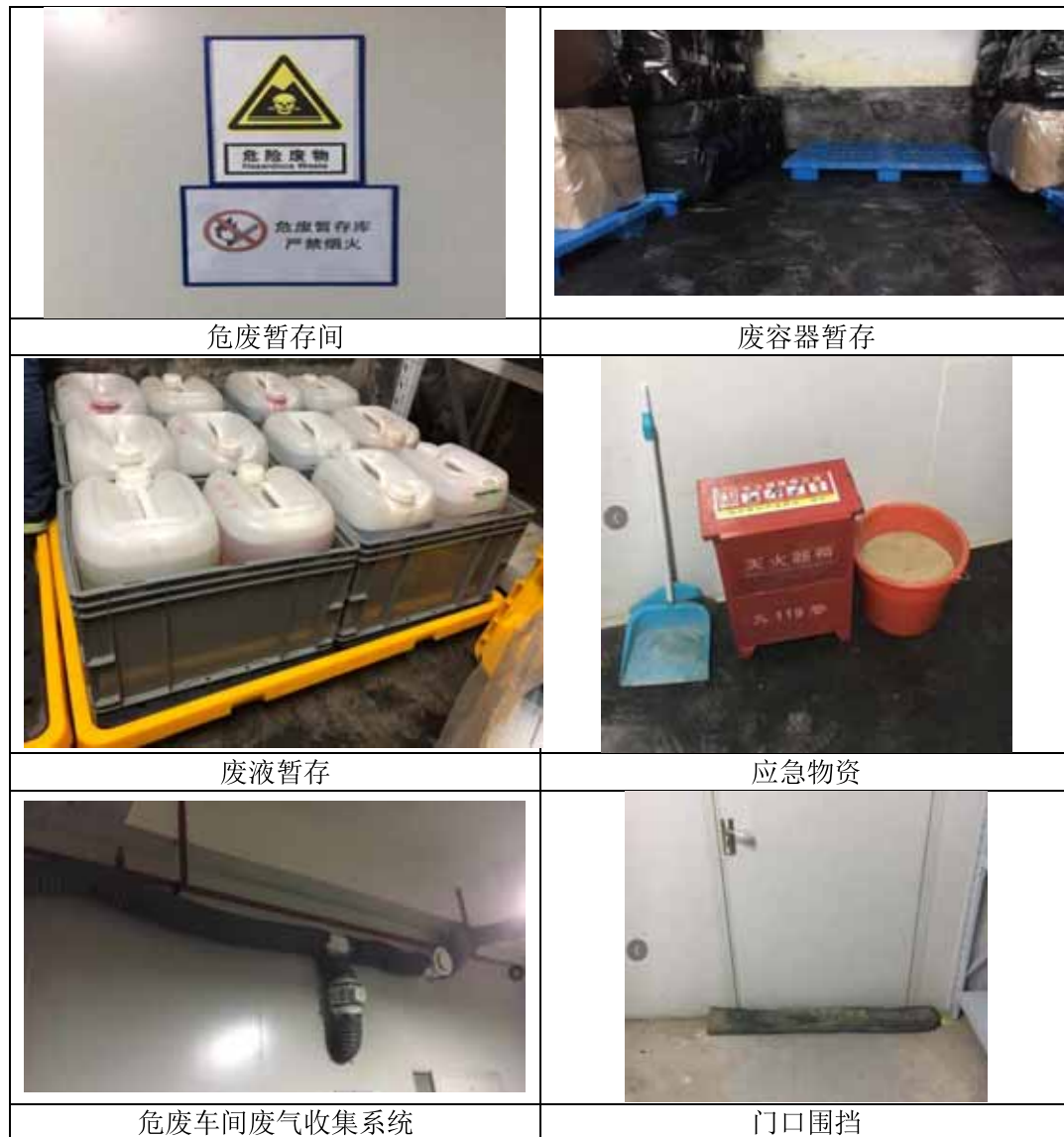
图 8 危废暂存设施照片
