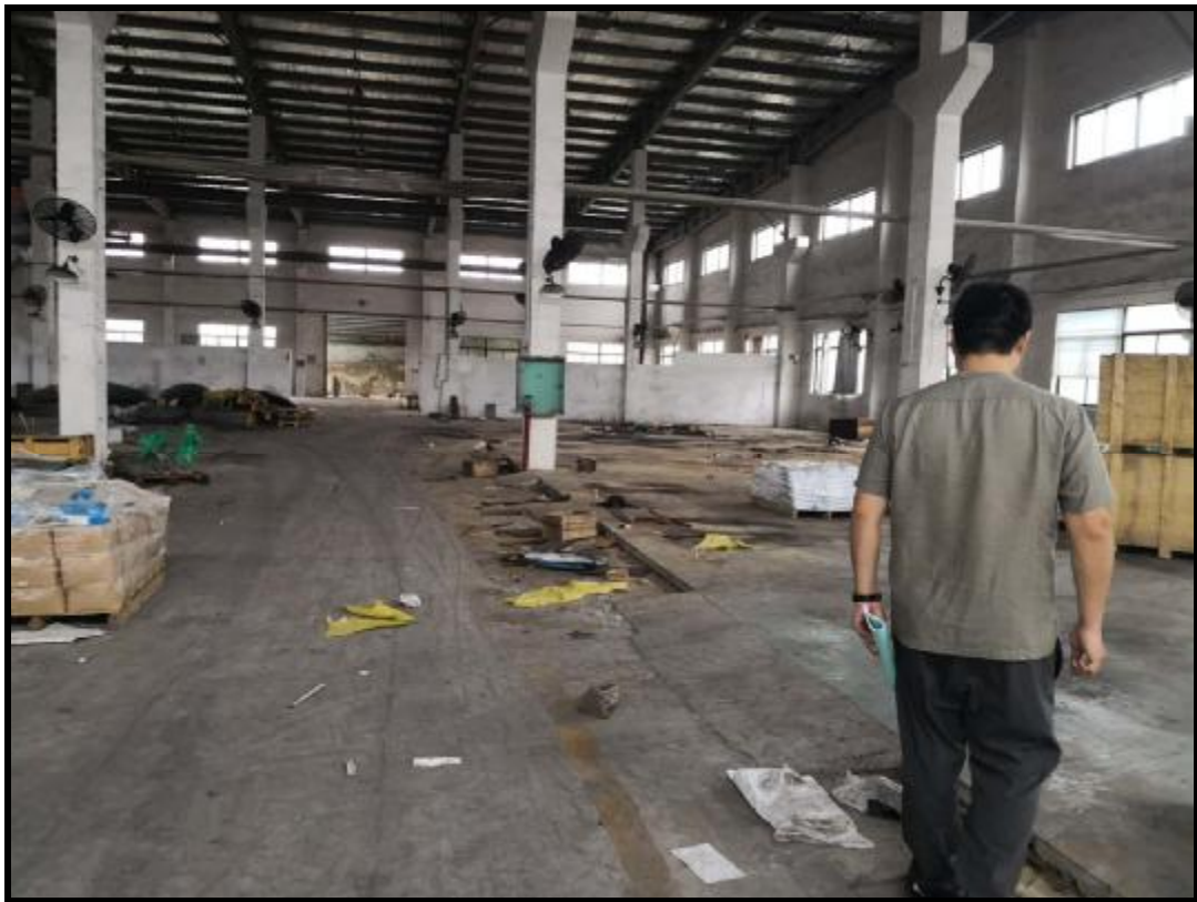
附图 6 工程师现场踏勘照片
